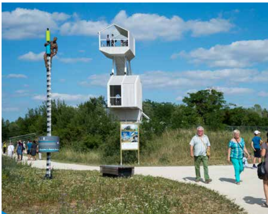
Un observatoire à l'architecture audacieuse permet d'admirer le Parc du Peuple de l'herbe à 13 m de hauteur
