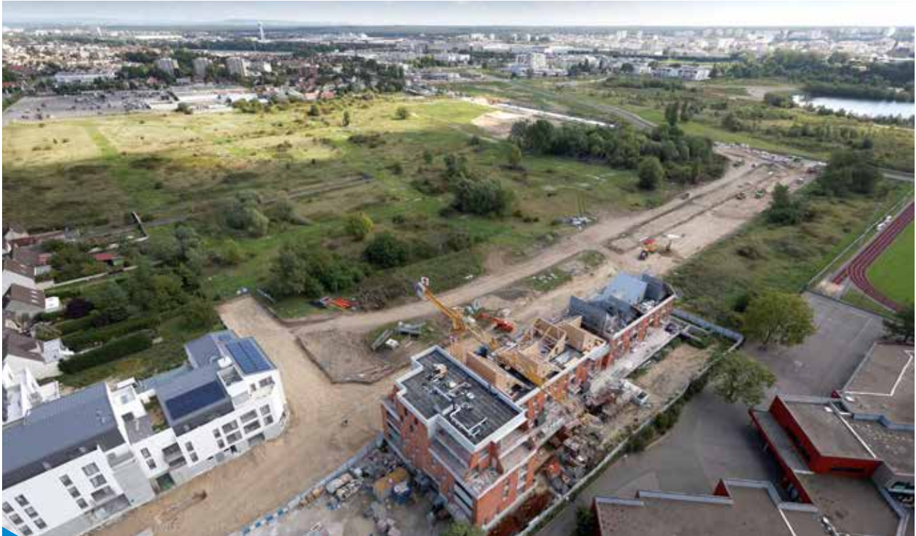
Pour répondre à la demande de logements, les constructions se poursuivent
