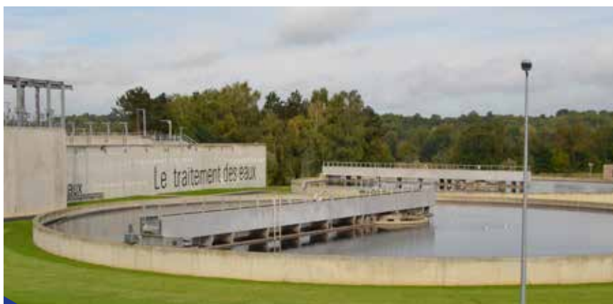
Après la reconstruction de la station d'épuration de Rosny-sur-Seine en 2013, celle des Mureaux va être lancée en 2017
