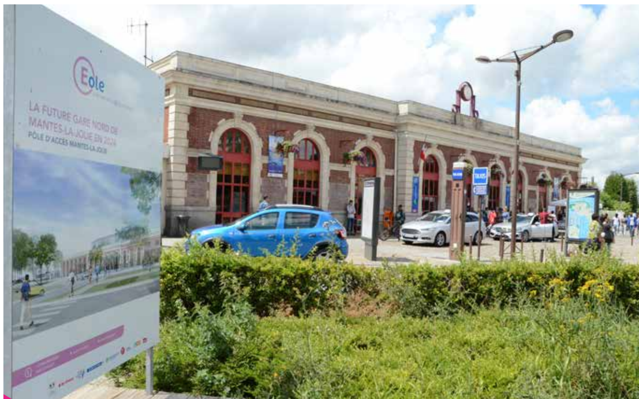
La gare de Mantes-la-Jolie bénéficie déjà de différents travaux pour se préparer à l'arrivée du RER E, annoncée en 2024
